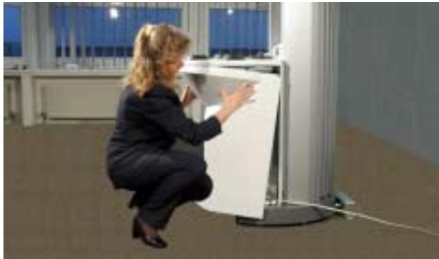
Kippen Sie die Frontverkleidung leicht unten von dem Gerät weg - also nach vorne. Dann führen Sie die Kante der Frontverkleidung oben in die Nut des Gerätes ein, bis Sie zum Gerät passt. Anschließend drücken Sie unten die Verkleidung an das Gerät an und befestigen die Schraube mit dem Schlitzschraubendreher.
